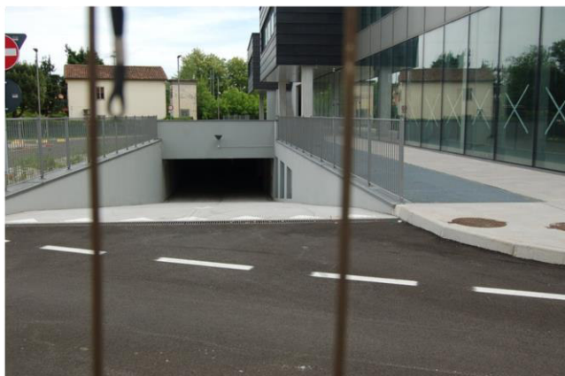
Vista del fronte est con la rampa di uscita dal piano interrato
