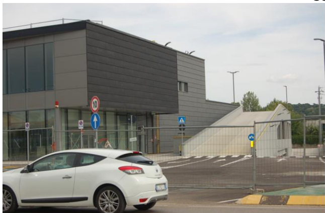
Vista del fronte ovest con la rampa di accesso al piano primo
