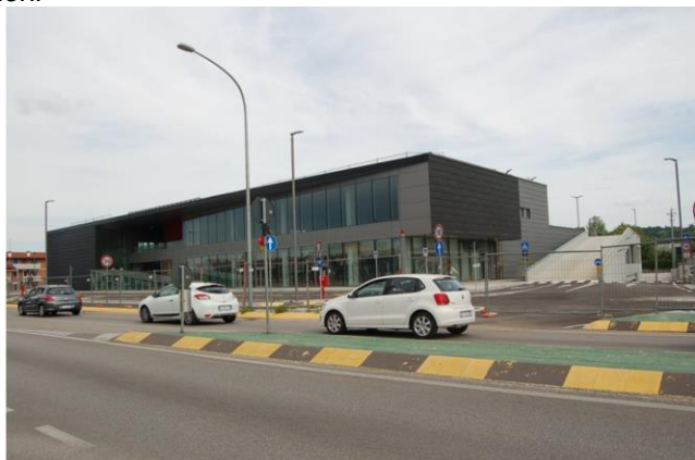
Vista del fronte nord dal marciapiede della SR11, fronte principale
