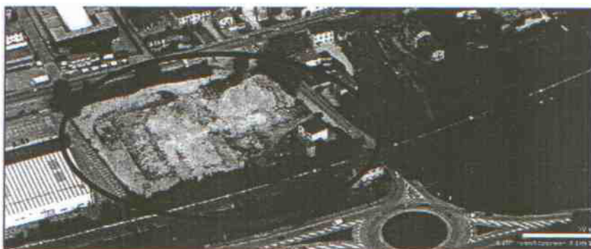
Particolare della zona con i vecchi edifici demoliti
