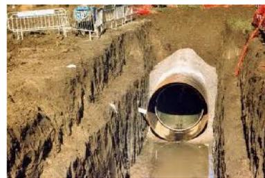
Tubo interrato in ferro di phi 400 per attraversamento stradale
