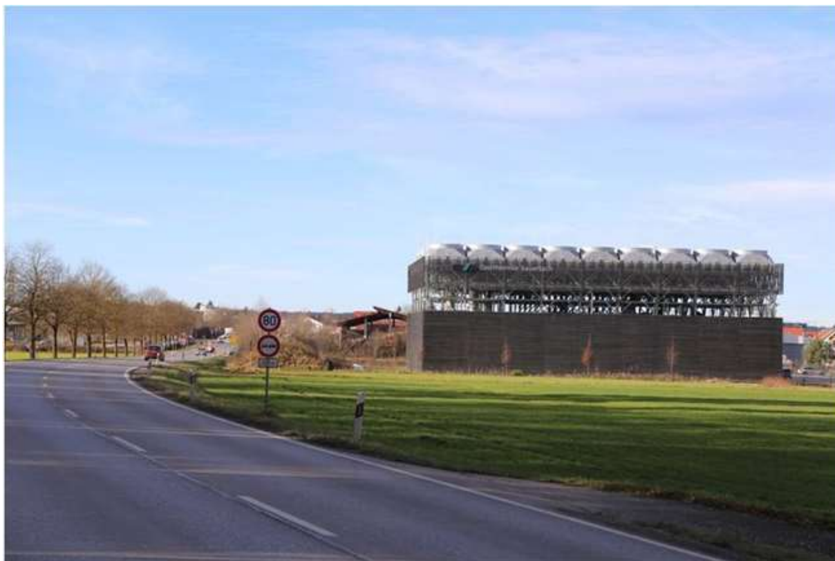
Fig. 2 – Centrale geotermica di Sauerlach – Baviera (Germania)
