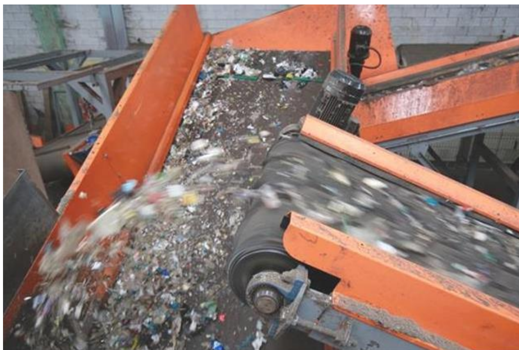
Foto 4. Materiale leggero e voluminoso in uscita dalla cabina aeraulica ed inviato al raffinatore.
