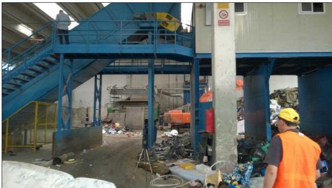
Cabina di selezione "Comer engineering"
