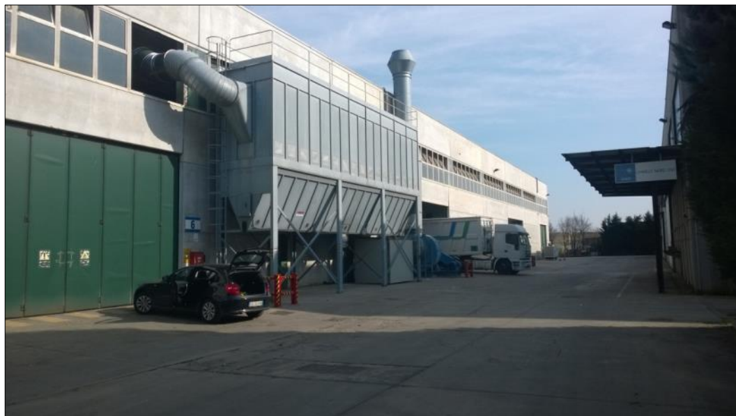
Vista generale dello stabilimento Futura s.r.l. di Montebello Vic.
