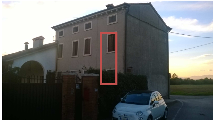
Foto n. 11 : Strumentazione fonometrica al punto 3 (segnalato in rosso il microfono)
