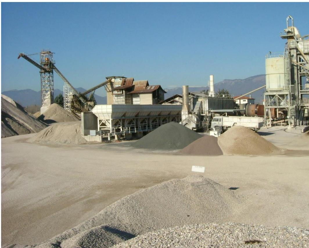
Figura 12. Interno del cantiere. Sulla destra l'impianto di confezionamento del conglomerato bituminoso, in primo piano le vasche predosatori dietro le quali verrà installato l'impianto di granulazione e vagliatura.
