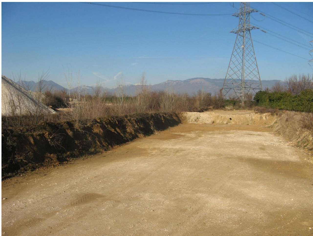
Vasca di essiccazione fanghi che percorre il confine est del cantiere. A destra è possibile notare la siepe che delimita il sito su tre lati.
