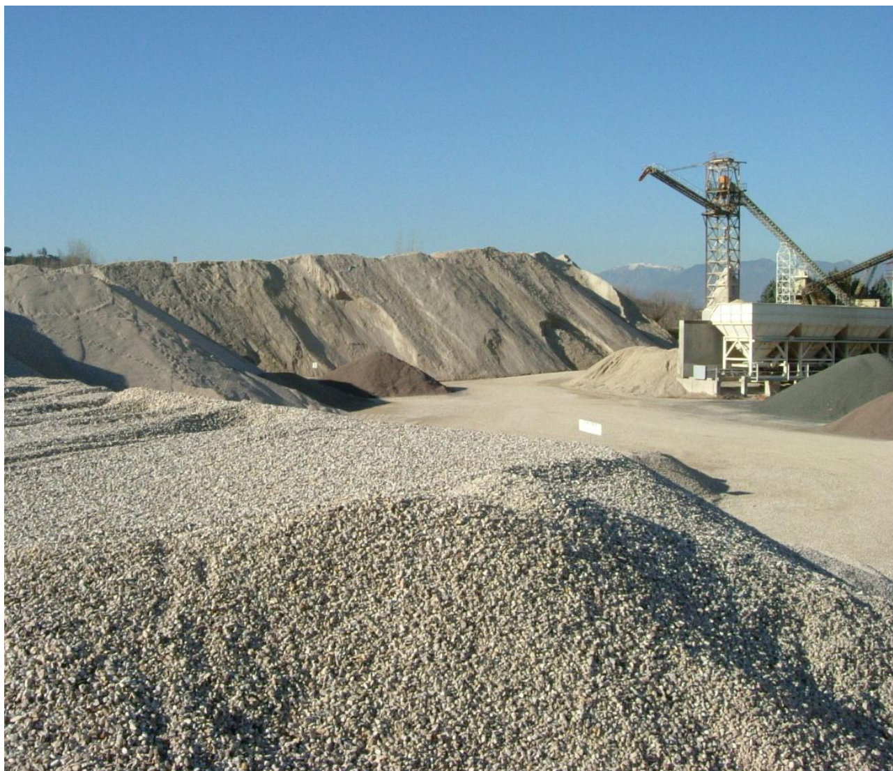
Cumuli di materiale inerte presenti al confine sud del cantiere.
