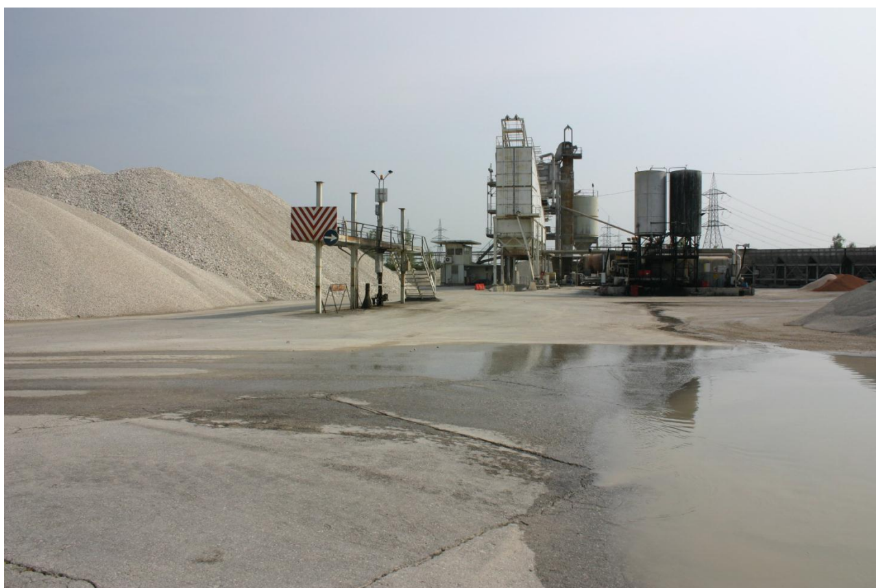
Impianto di confezionamento del conglomerato bituminoso. Si notano sulla destra i silos per lo stoccaggio del bitume.
