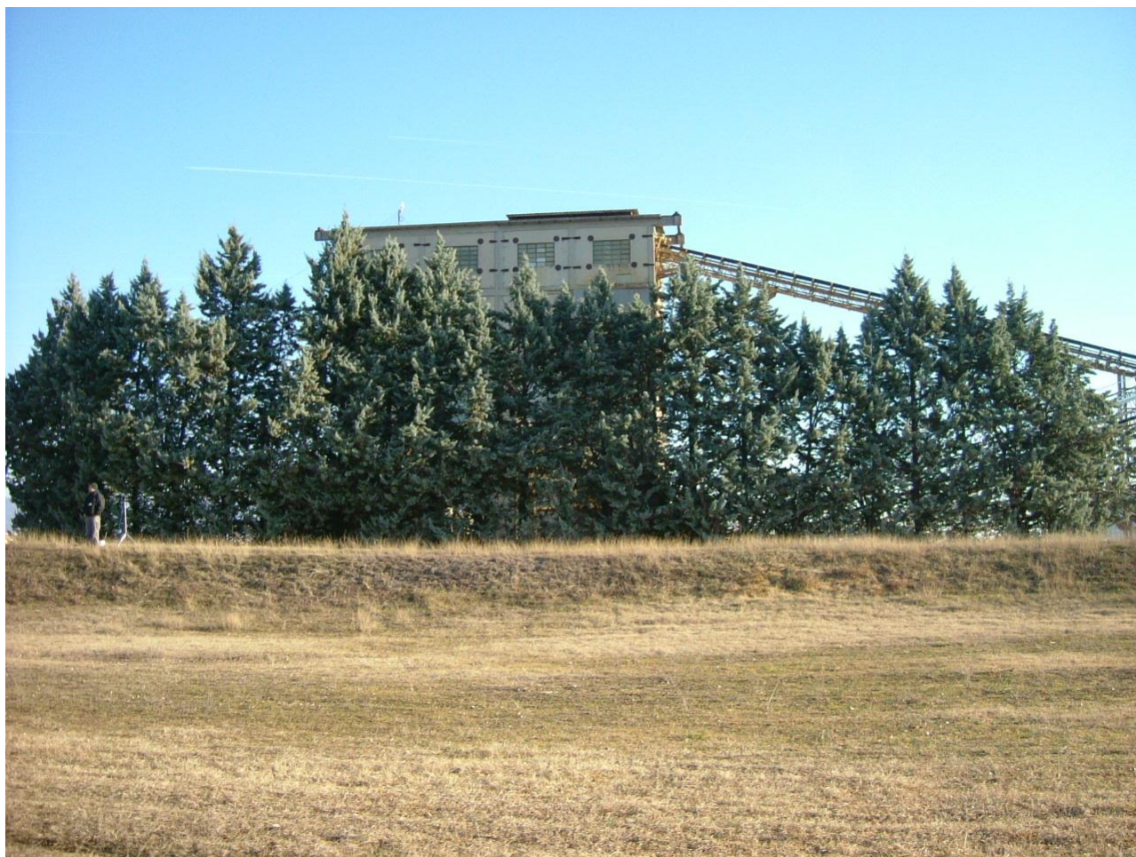
Impianto per lavorazione inerti, lato ovest.
