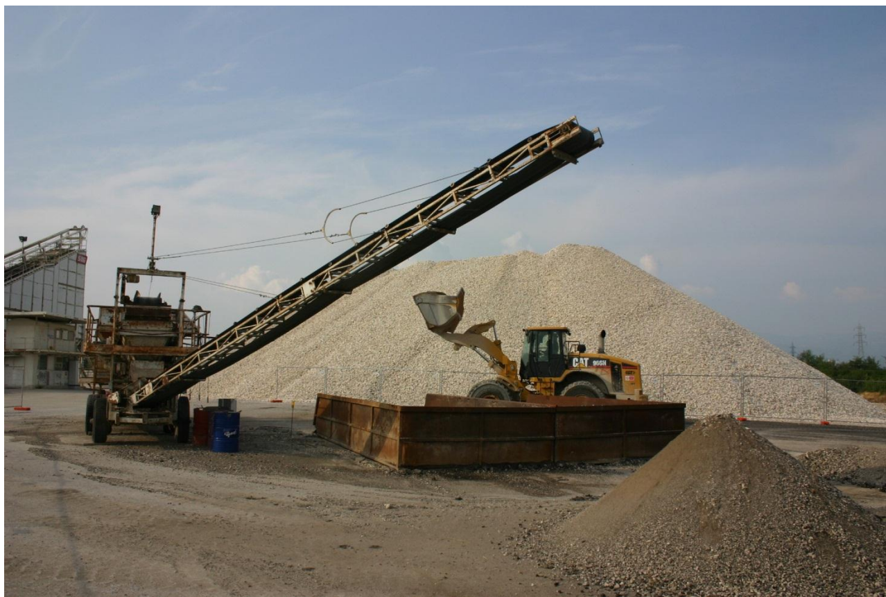
Operazioni di carico nell'attuale impianto di recupero rifiuti a servizio della mesa in riserva B.
