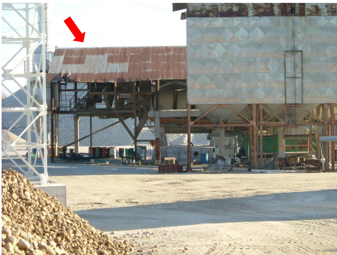
Copertura sotto cui verrà realizzata la messa in riserva A.
