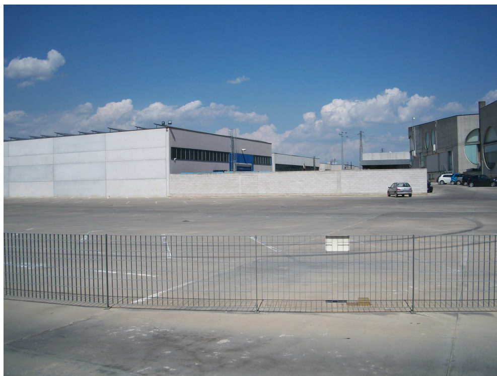
Foto 3 - Vista del piazzale esterno
