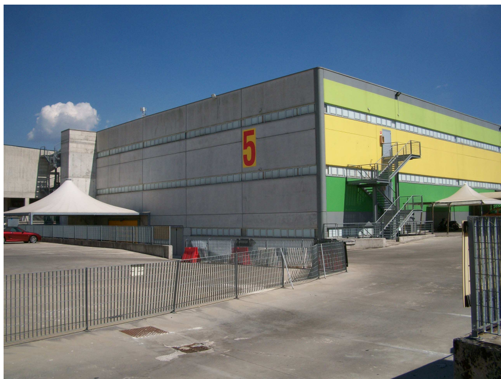
Foto 1 - Vista del corpo principale dal retro
