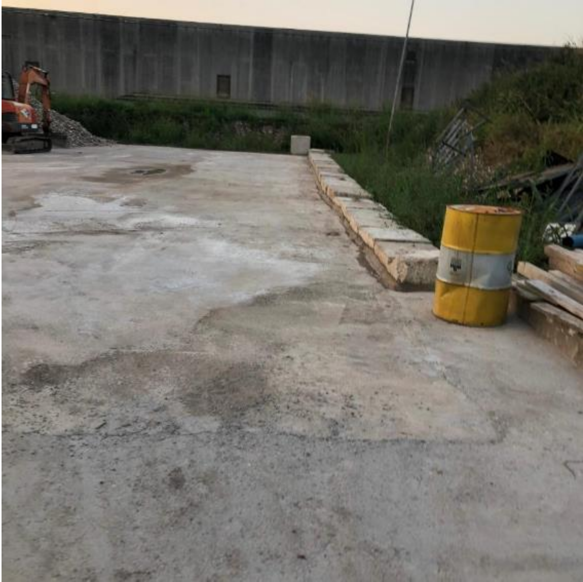
Foto 15. Dettaglio del cordolo di contenimento (1)
