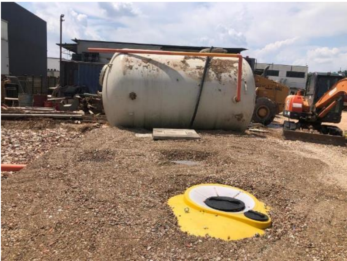
Foto 14. Sistema di trattamento (finito)
