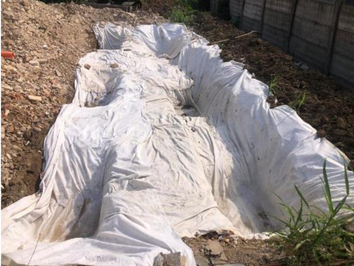
Foto 9. Sistema di dispersione in fase di realizzazione
