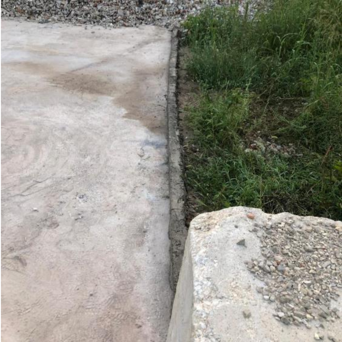
Foto 16. Dettaglio del cordolo di contenimento (2)
