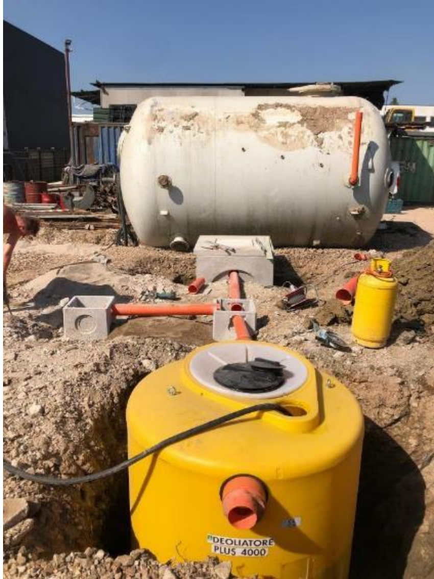
Foto 12. Sistema di trattamento in fase di realizzazione
